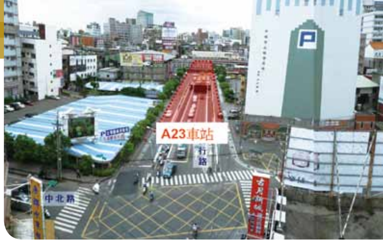
● 機場捷運中壢車站（A23）預定地
